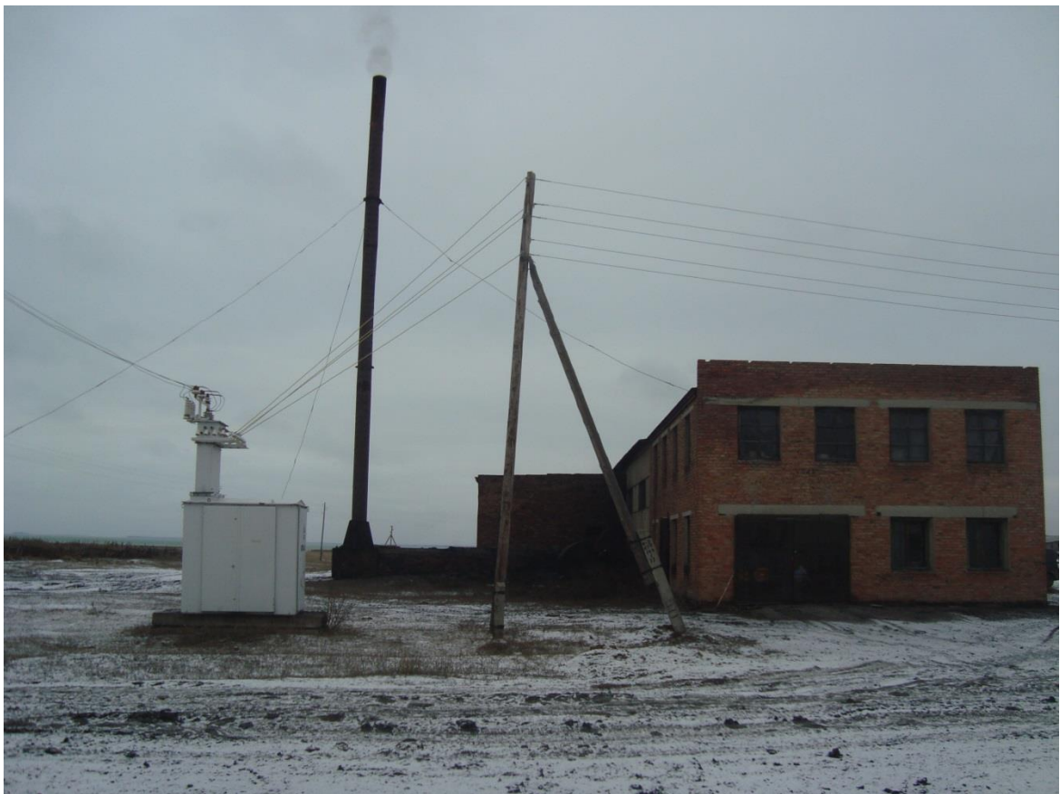
Рисунок 1.2 – Котельная с. Новоярково
