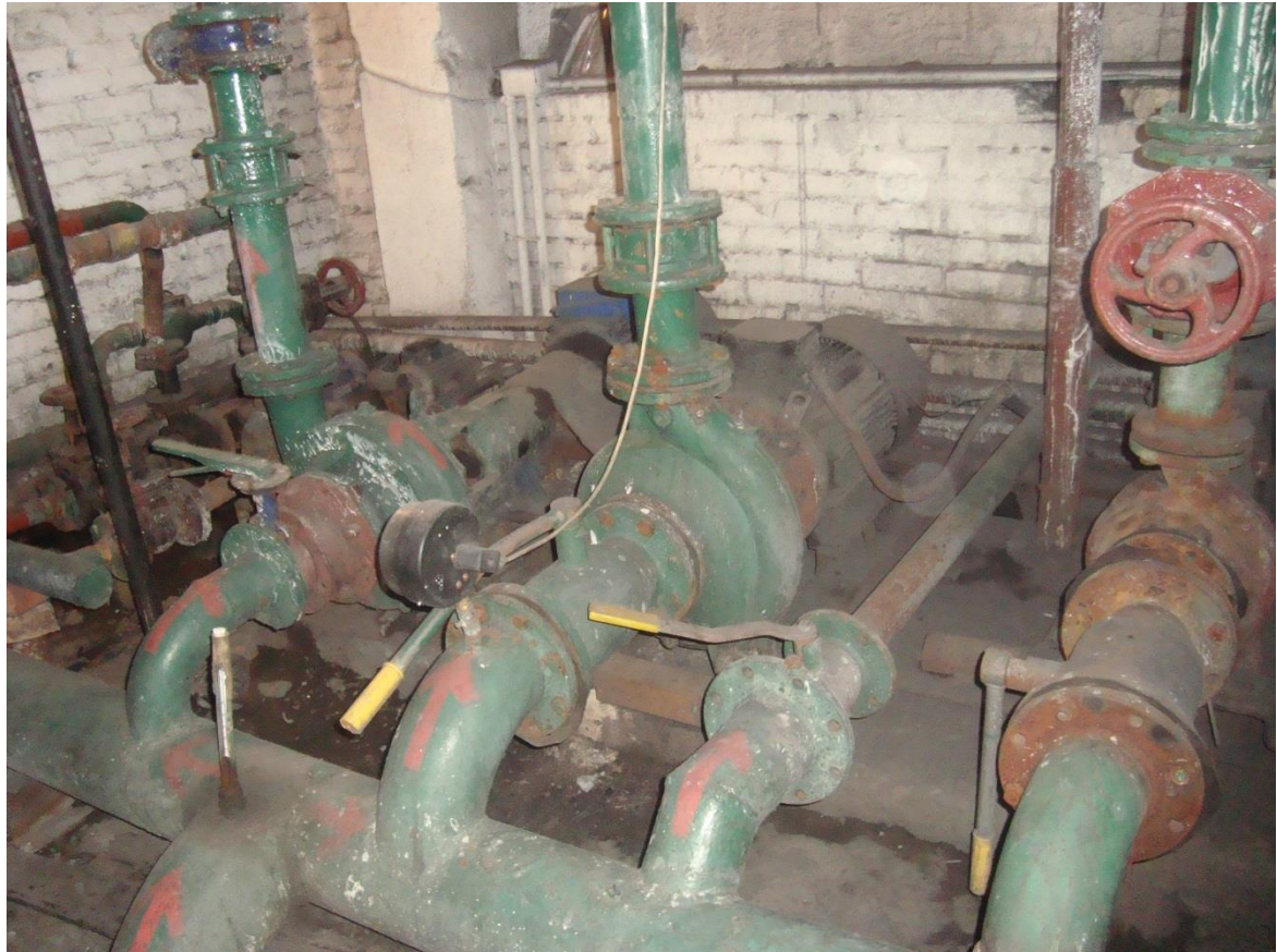
Рисунок 1.4 – Состав оборудования насосных групп котельной с. Новоярково
